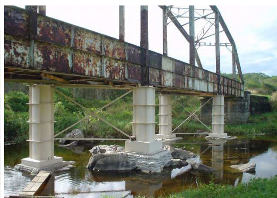
Reforço Ponte Acajutiba –BA Ano 2003
