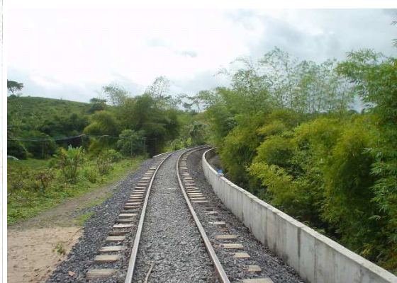
Muros e trilhos S. Amaro – BA KM 401 Ano 2002
