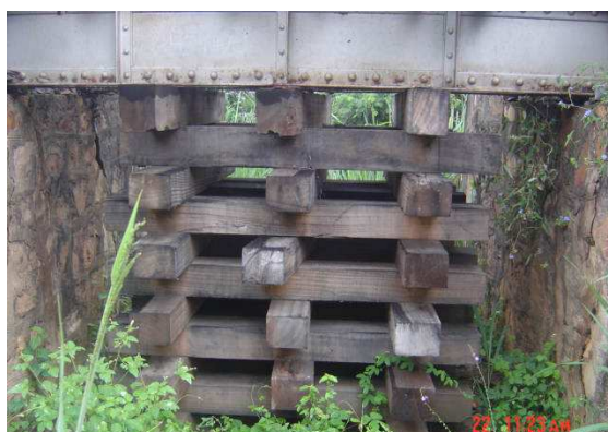
Reforço Bueiro - SE KM 454 Ano 2005
