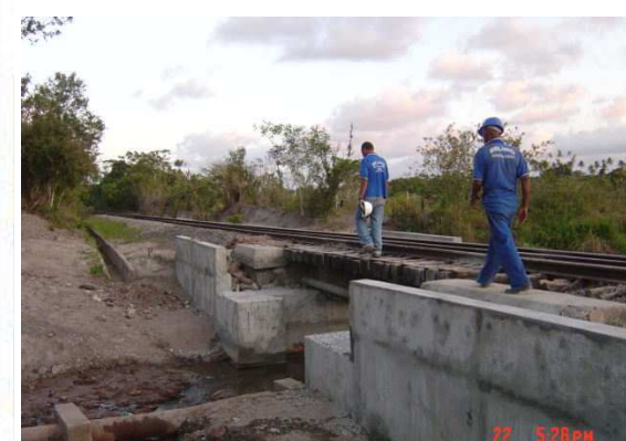
Ponte de Salgado-SE KM 350 Ano 2006
