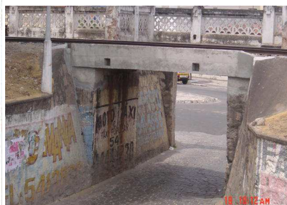
Ponte de Bomfim-BA KM 439 Ano 2005
