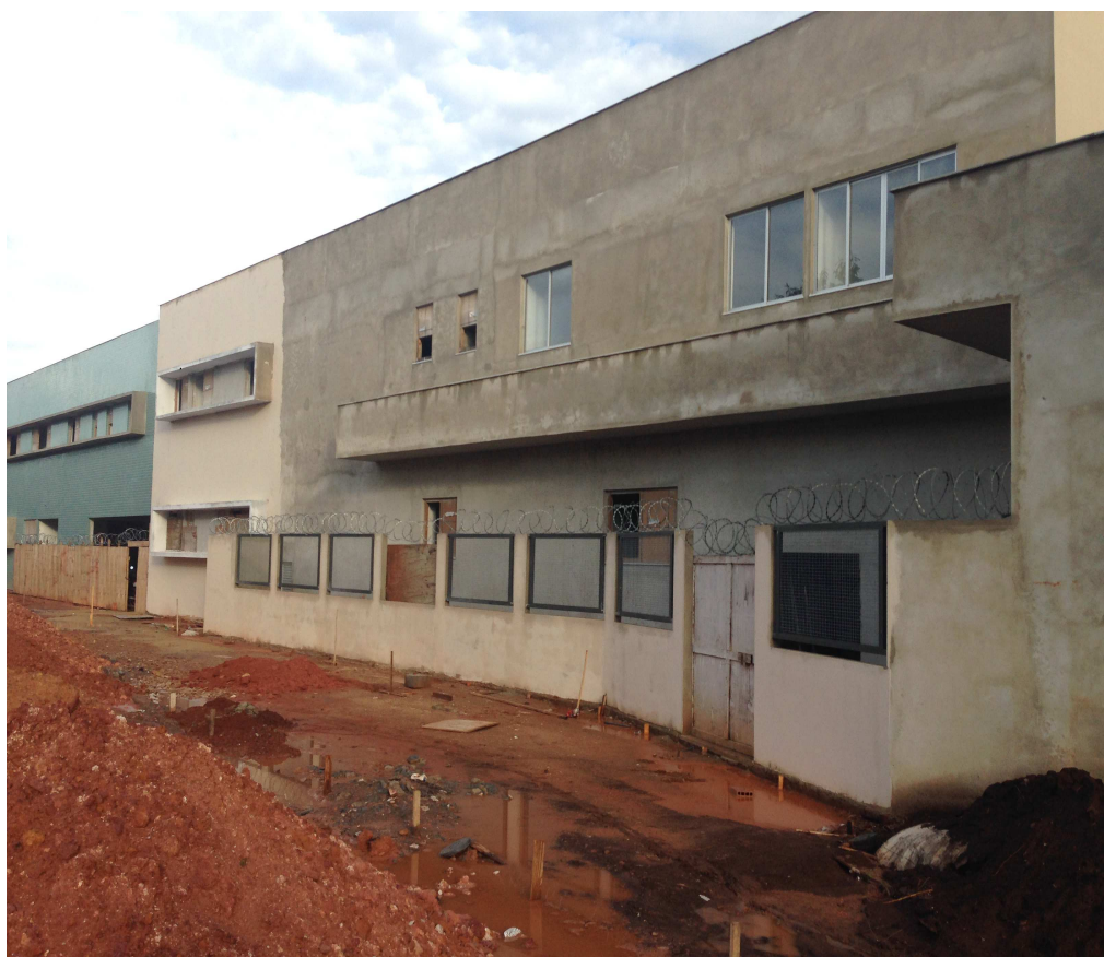
UPA – Unidade de Pronto Atendimento – Regional Leste Área Total: 7.500 m 2 Entrega Prevista: Jul/2015 Belo Horizonte – Minas Gerais
